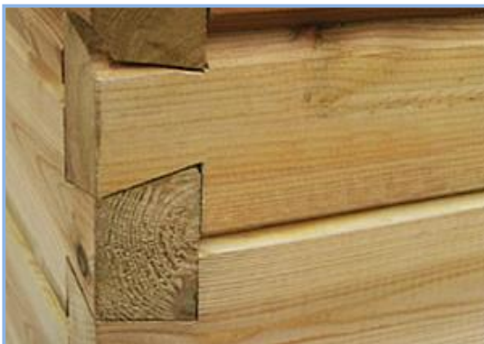
Fig. 29 Ensamble de en cola de milano.
